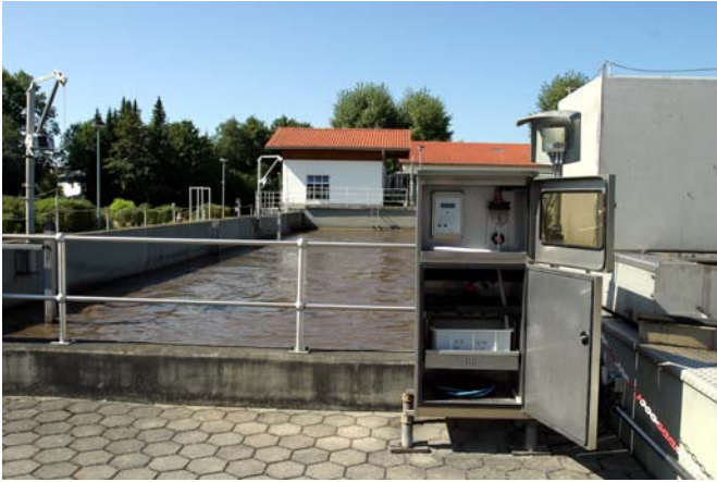
Beprobungseinrichtung am Ablauf des Anaerobbeckens
