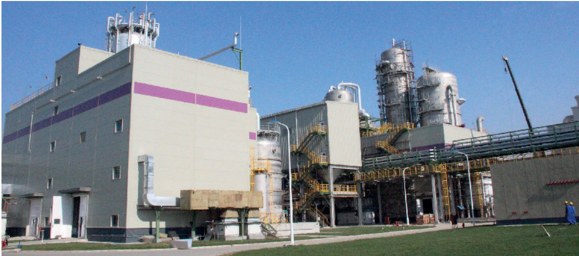
Wasserstoffperoxidanlage von Evonik im chinesischen Jilin.
