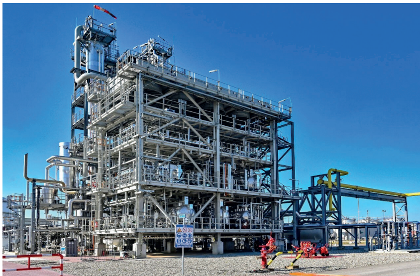
Im November 2024 wurde im Shell Chemicals Park Moerdijk in den Niederlanden der Market Development Upgrader (MDU) eröffnet. Damit kann Pyrolyseöl aus recyceltem Kunststoff wieder als Rohstoff für die Herstellung von Grundbestandteilen für neuen Kunststoff verwendet werden. (Foto: Shell/E.Bode)
