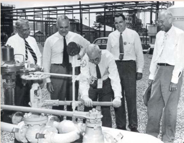
Karl Ziegler (in der Mitte) bei der Inbetriebnahme der HITAX-Anlage von Hercules Powder in Parlin, N. J., im Juni 1957: Die erste Produktionsanlage für High Density Polyethylen in den USA.
