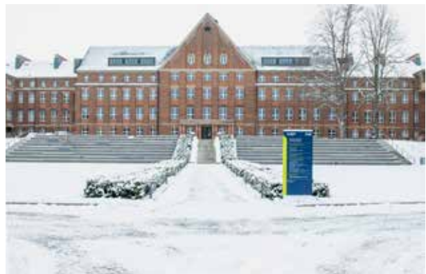
Abb. 11: Der sanierte Fritz-Foerster-Bau und der neu gestaltete Innenhof des Gebäudeensembles im Winter 2022 (Foto: Michael Kretzschmar).
